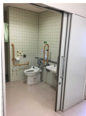
多目的トイレ
