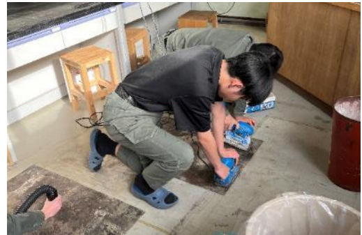
実習室床補修
