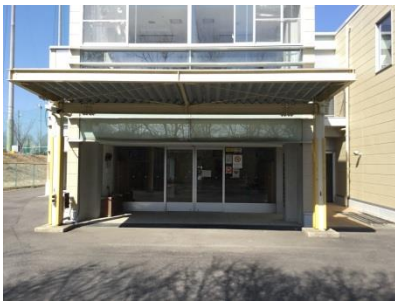
玄関・警報装置
