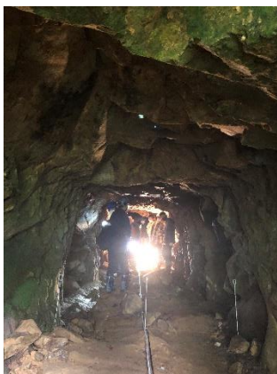
素掘部分の状況
