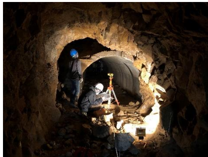
素掘・コンクリート接続部分
