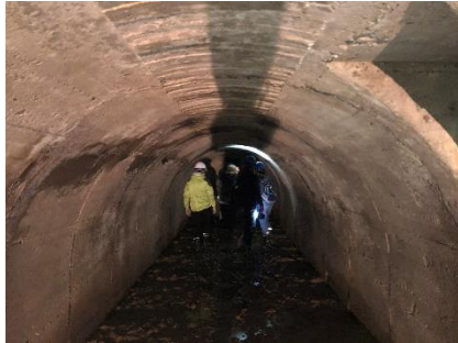
コンクリート舗装の状況
