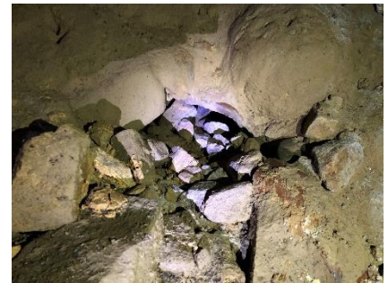
排水溝・排水管
