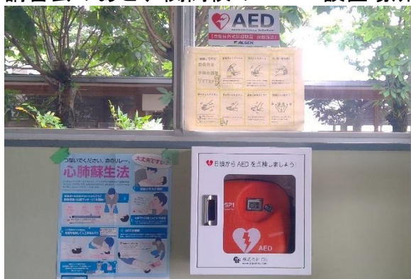
保健室前の廊下
