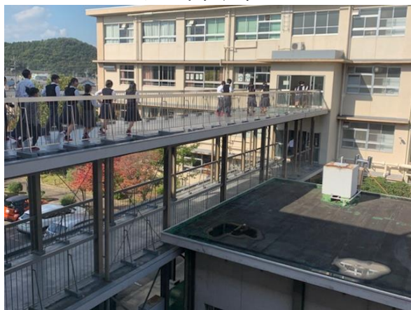
渡り廊下を使ってしっかり避難しています。
