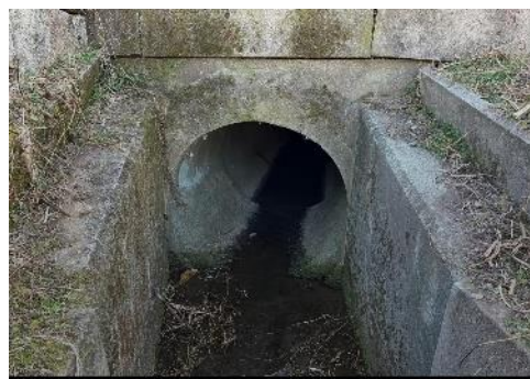
写真6 暗渠の排水溝
