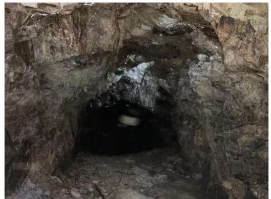
写真 9 地下壕内部写真
