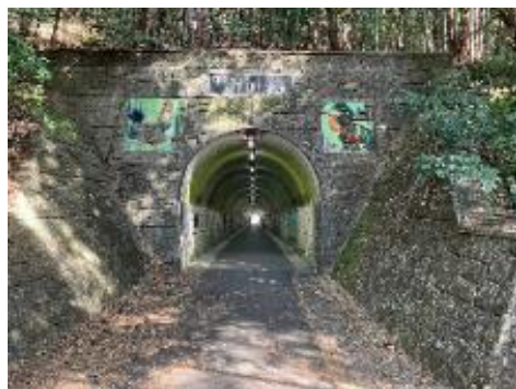
写真 12 旧常盤トンネル西
