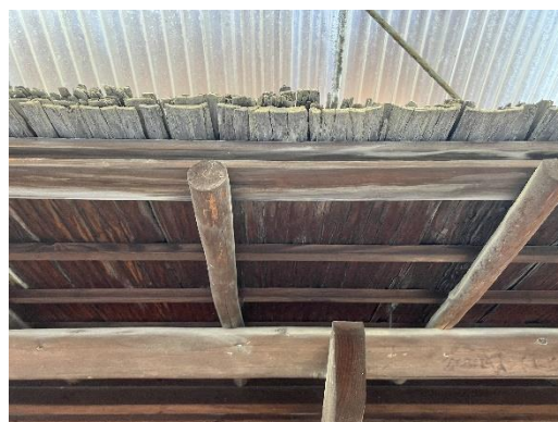
写真4 樽板製のひさし（下面） ※ともに、加茂郡七宗町神湊の民家
