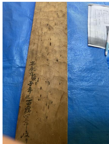
写真 18 祖師野八幡宮元和三年棟札 チョウナ痕の残る裏面
