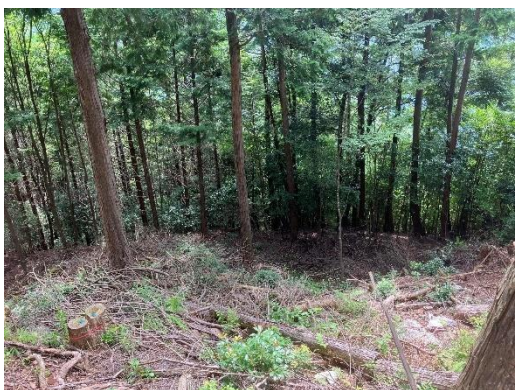
帯曲輪の遺存状況を上方より確認
