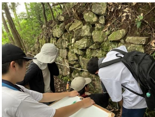
南西櫓台南辺石垣の測量
