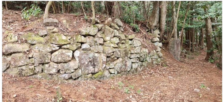
櫓台Aの南西側の石垣(南から)
