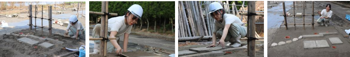
「縁石」からの続きに玉石を設置し、あとは植物の植込みと敷地内の清掃で完成です!! ...この繰り返しを試験日まで1週間続けました。
