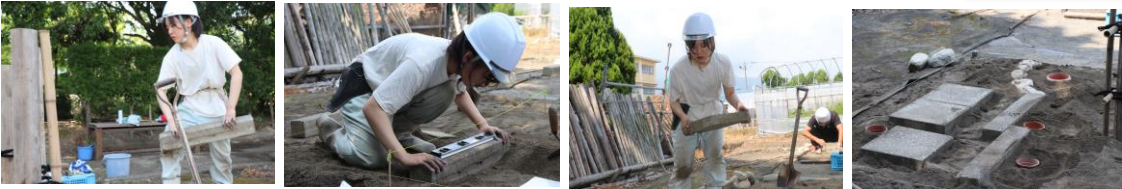
コンクリート製の「縁石」と「石板」を地面に水平に固定します。縁石は5Kgほど、石板は3Kgほどもありとにかく重いです!!
