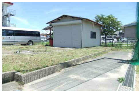
写真 2 電子機械科棟東側倉庫
