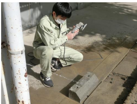
仕上げの様子
