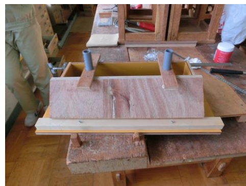
完成した型枠
