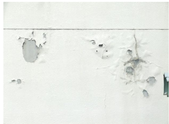
写真2 外壁の剥がれているところ
