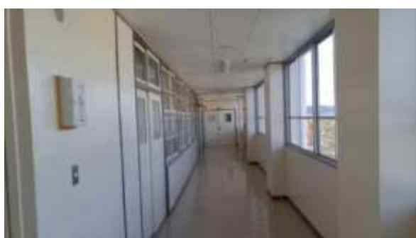
廊下の壁や窓枠も塗装を実施
