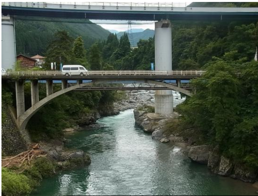
アーチ型の朝六橋 (7月27日下呂市小坂町)
