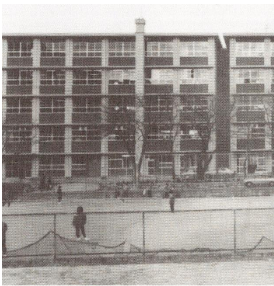
第3期工事（5階建部分1年生昇降口まで）
