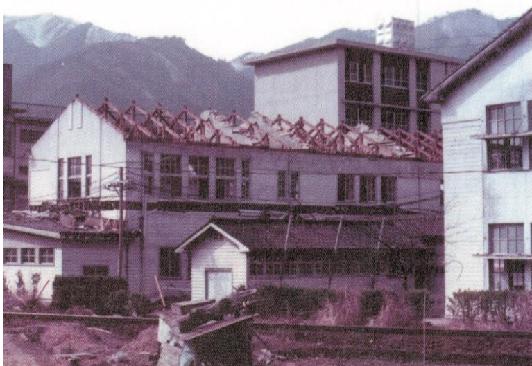
新校舎建設と同時に進む旧校舎の解体工事
