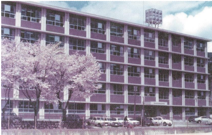
第2期工事（5階建部分2年生昇降口まで）
