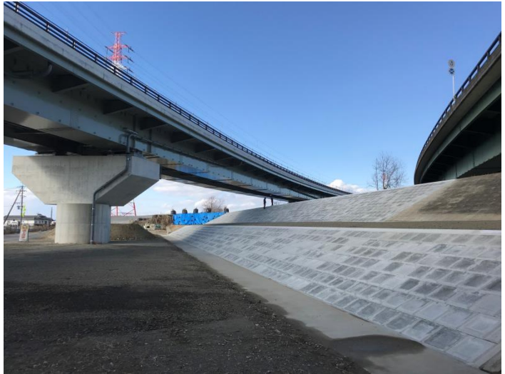
※河川工事の完成風景
