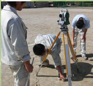
トータルステーション測量
