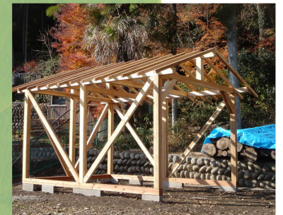
建築材の加工と組み立て
