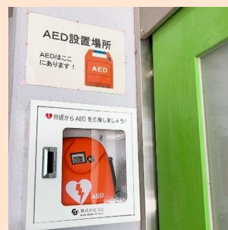
多目的ホール出入口
