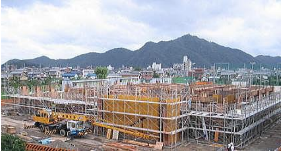
建設工事（9月上旬）
