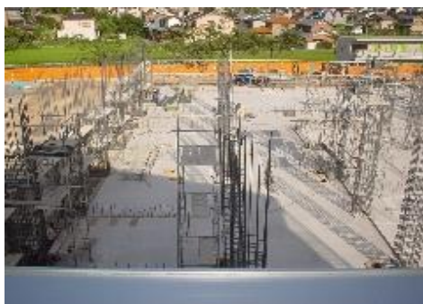
建設工事（8月上旬）
