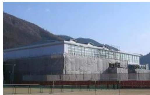
建設工事（05年1月下旬）
