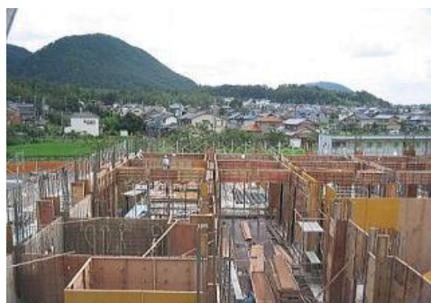
建設工事（8月下旬）
