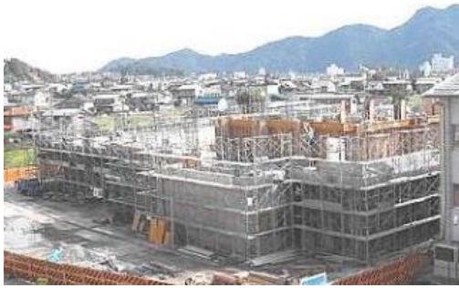
建設工事（9月下旬）
