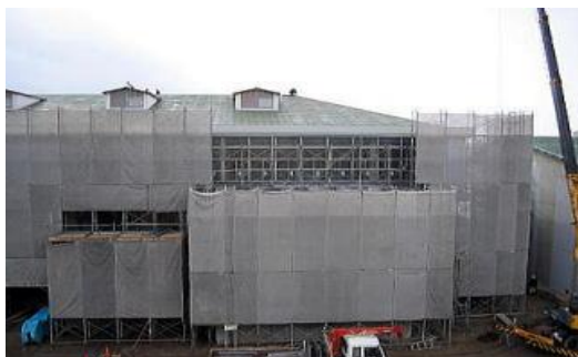
建設工事（05年1月上旬）
