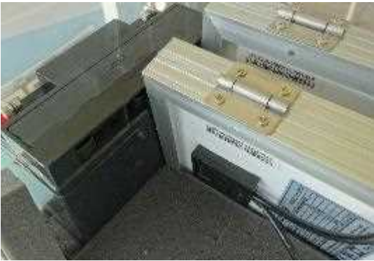
Fig 16 バッテリーを交換した
