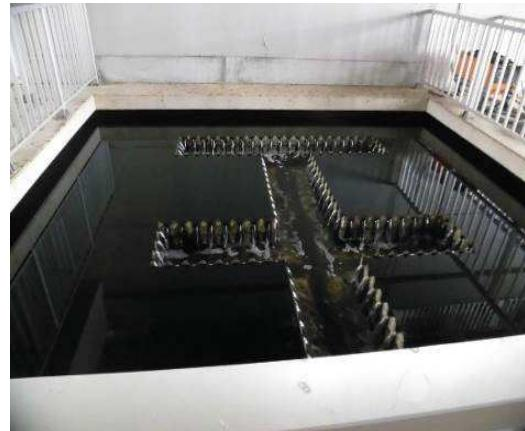
Fig. 5 急速砂汙過法
