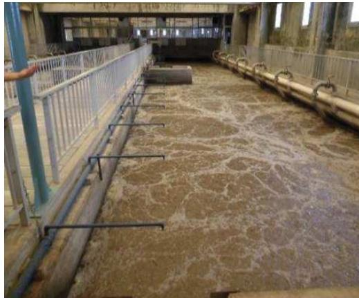
Fig. 4 北部プラント生物反応槽
