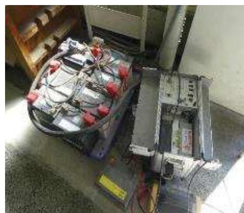
Fig. 7 完全密封型鉛蓄電池
