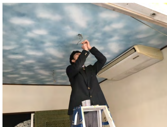
Fig.18 内装および電気工事
