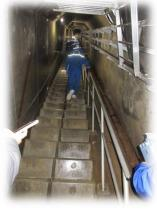
\*ダム内の点検用通路 傾斜角は45度!!
