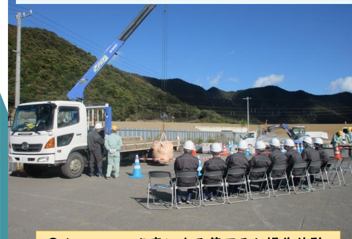
●4+ユニック車による荷下ろし操作体験
