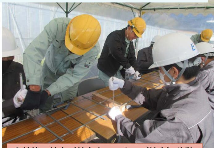
●鉄筋の結束（針金をハッカーで結束）体験
