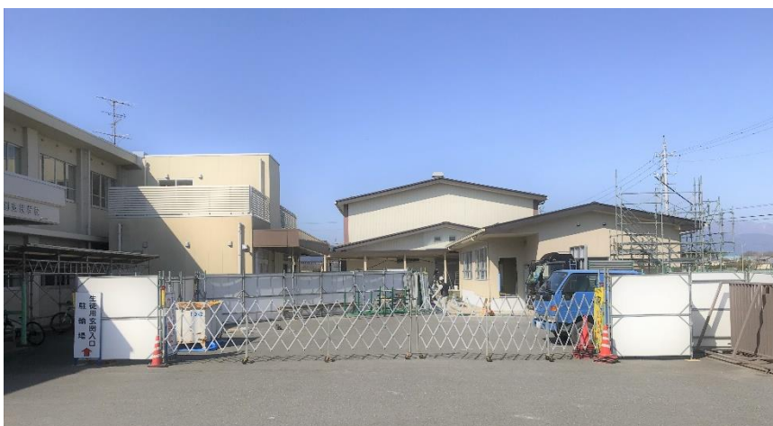
新校舎の工事も進んでいますよ。
