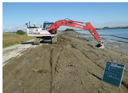
ICT建機による整形状況
