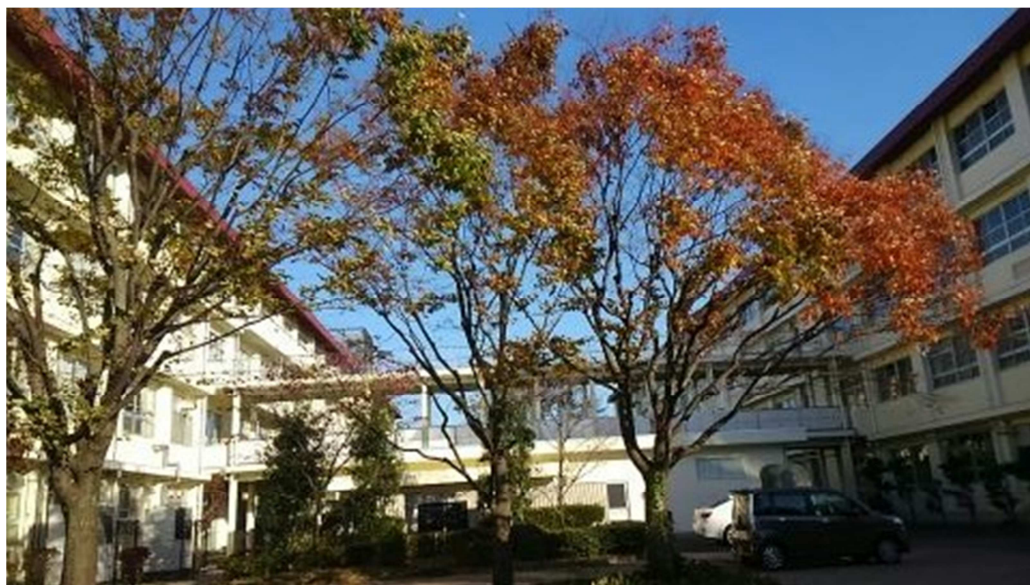
西昇降口付近。
